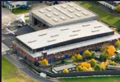
CGN: 5400 m 2 Hangar
